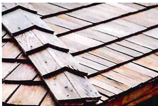
Ryc. 9. Dach z gontu drewnianego
